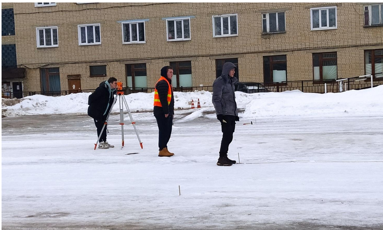
Рисунок 1. Разбивка проекта вертикальной планировки на местности
