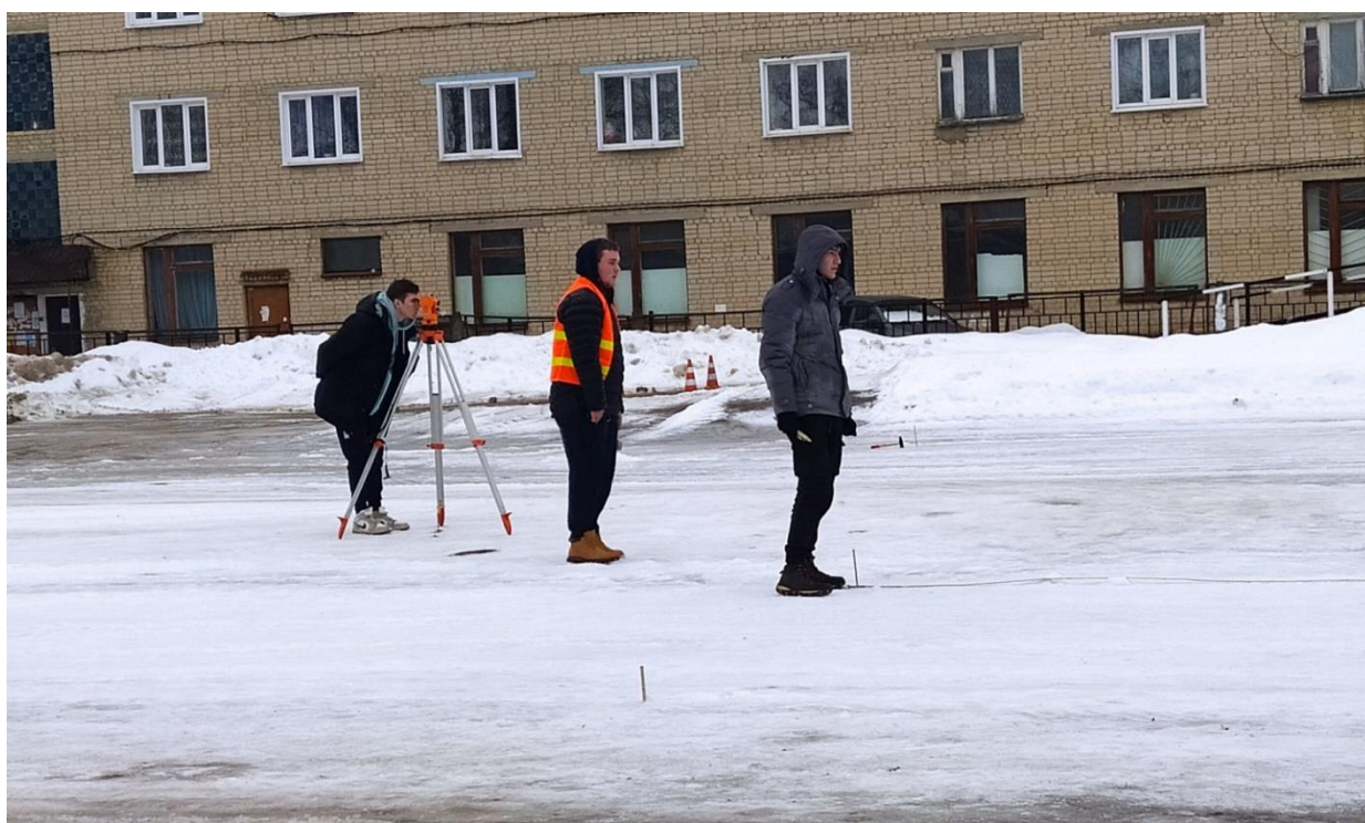
Рисунок 1. Разбивка проекта вертикальной планировки на местности
